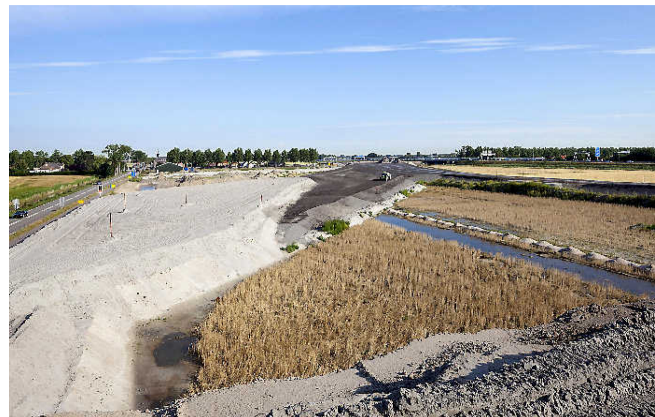
Badhoevedorp/Lijnden 2014: de omlegging van de A9.
